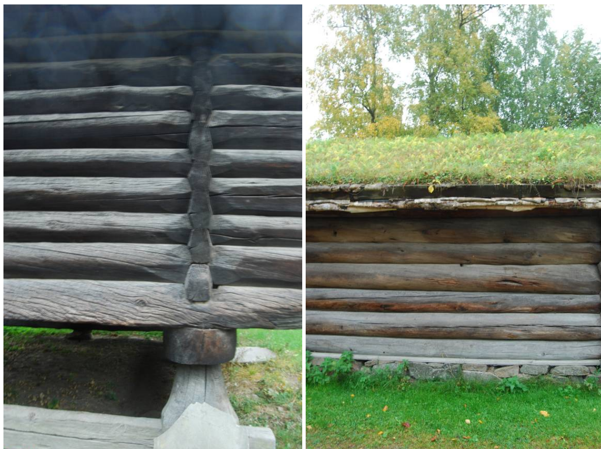
Fig.1.6 b Structuri din lemn și îmbinări constructive din Norvegia (Muzeul Satului, Oslo)
